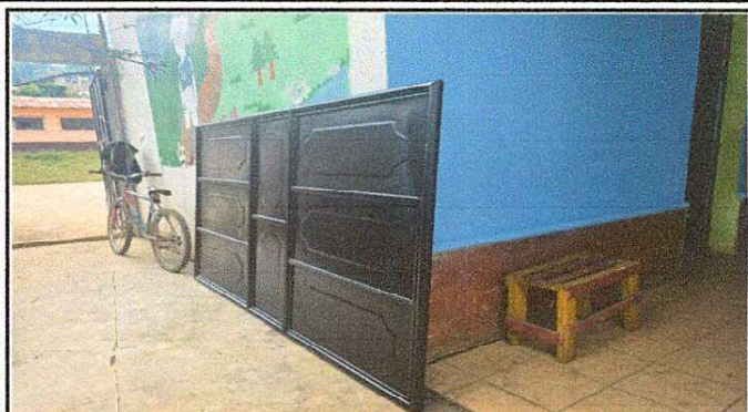
Foto 2: SUSTITUCIÓN DE PUERTA DE METAL POR DETERIORO.
