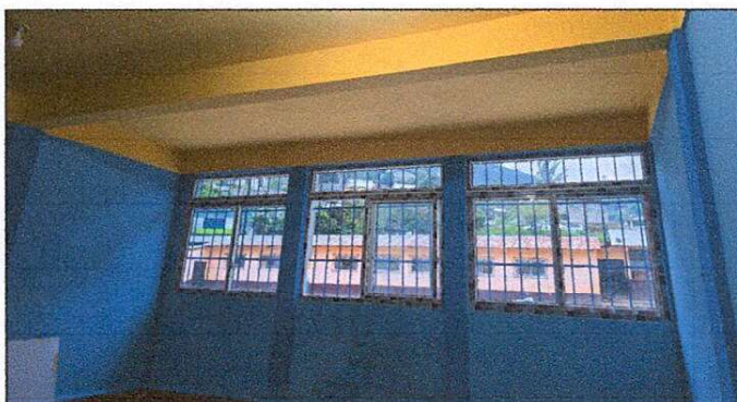
Foto 3: COLOCACIÓN DE VENTANAS EN AULAS.
